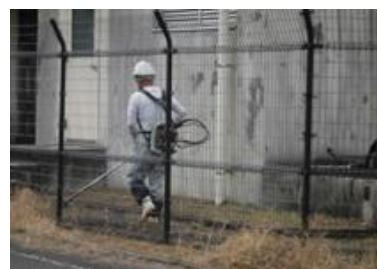
草刈作業（浄水場）
